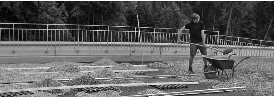
■ Abbildung 2: Vorbereitungsarbeiten für den Bau der PV-Anlage auf dem Dach der sfb: zuerst 10t Kies zur Seite schieben, Bautenschutzmatte und Montagegeschienen verlegen und dann die 10t Kies wieder zurück.
