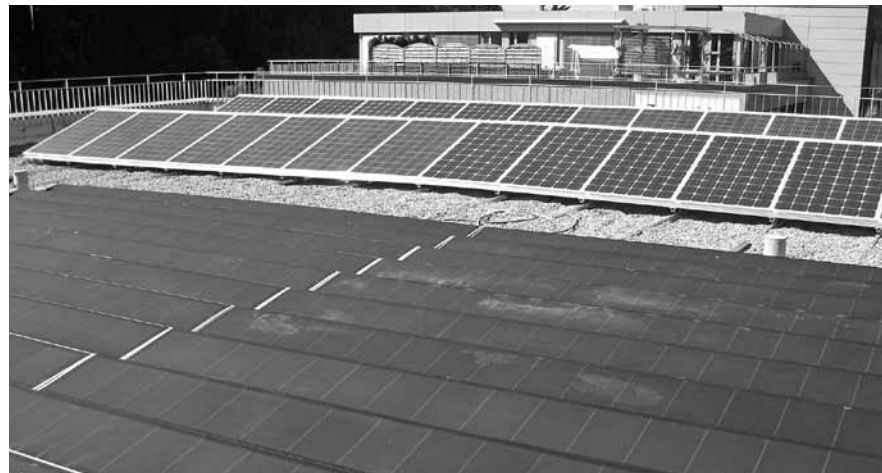
■ Abbildung 4: Panele montiert (vorne die Dünnschichtzellen, hinten die polykristallinen (hell) und die monokristallinen Zellen (dunkel)).
