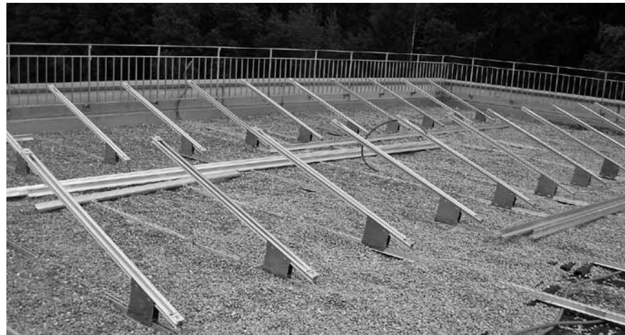
■ Abbildung 3: die vorbereiteten Montageprofile und Zuleitungen für die Panele
